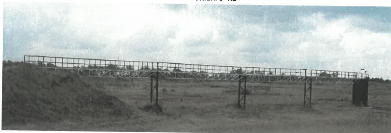
Pomost do studni S-4.2
