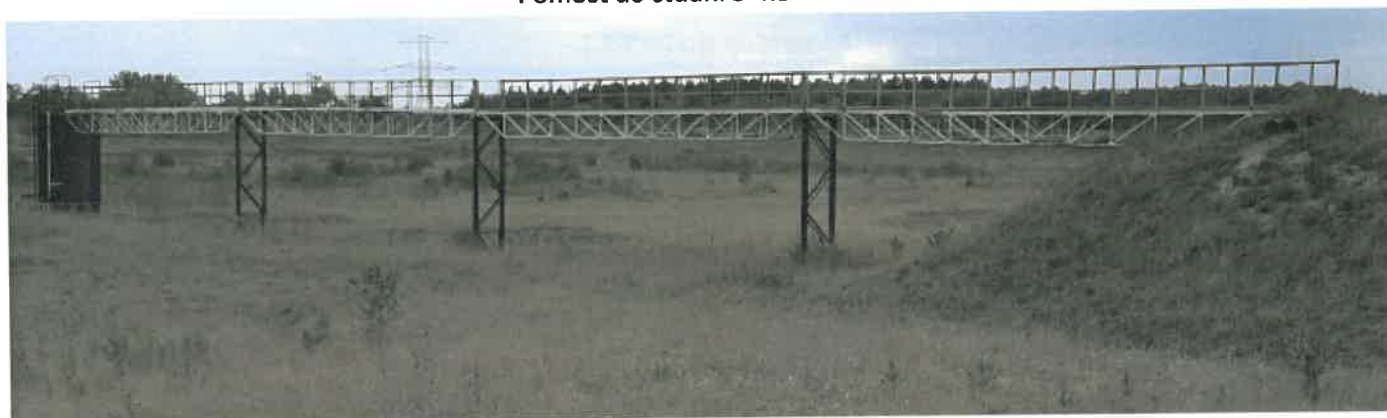
Pomost do studni S-4.3
