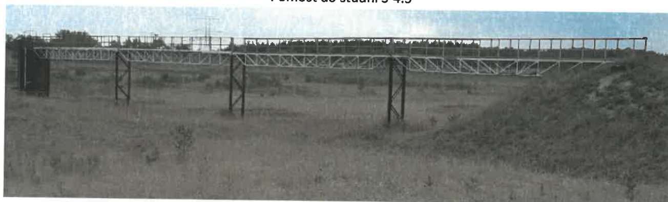
Pomost do studni S-4.3
