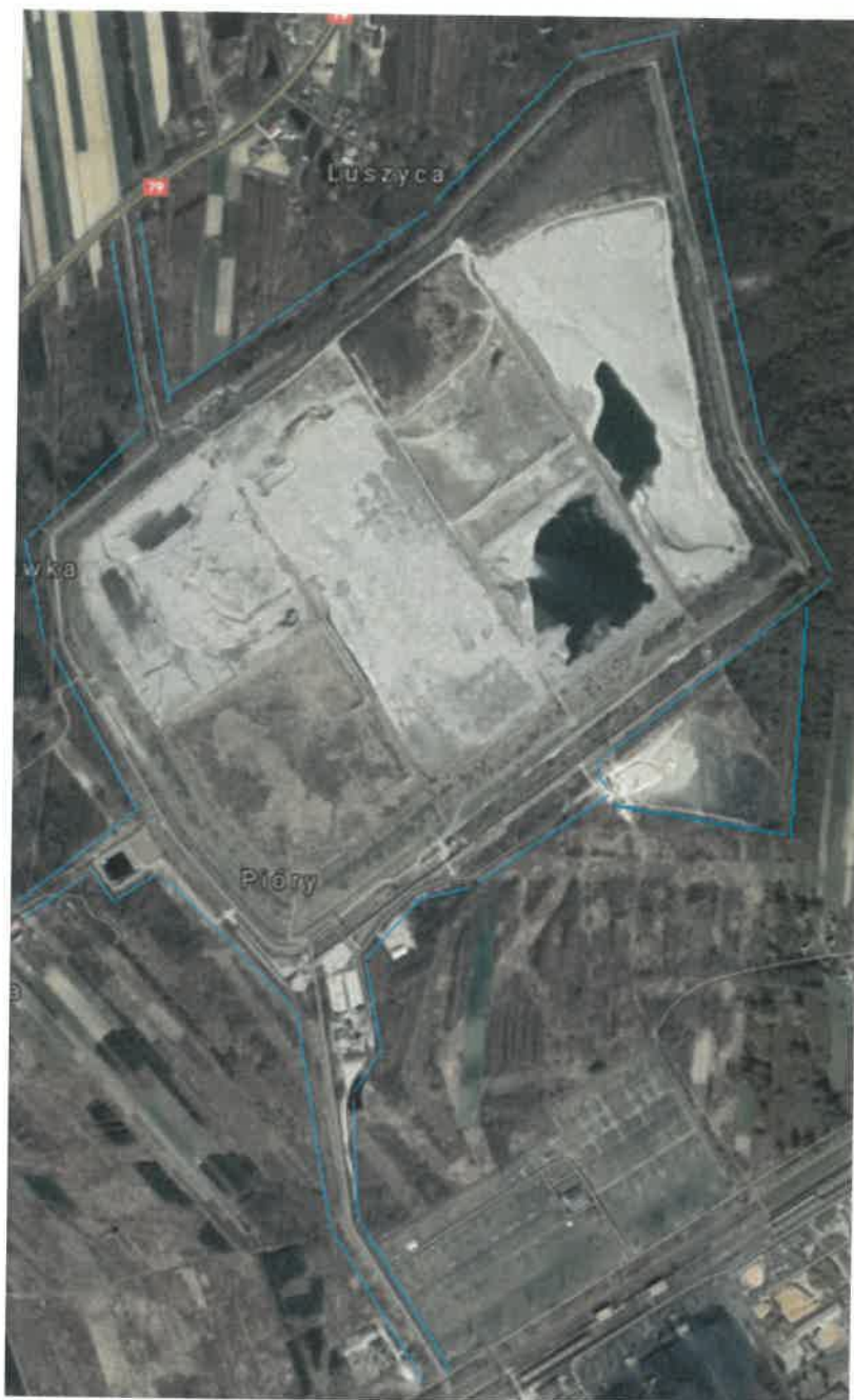
Rys. 1. Teren składowiska „Pióry” i magazynu „Tursko”.
