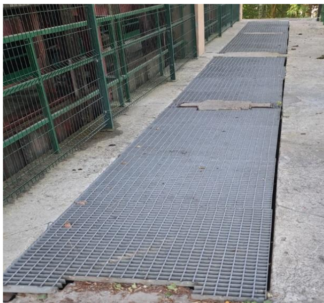
Rysunek 1. Miejsce wkładania zastawek remontowych.
