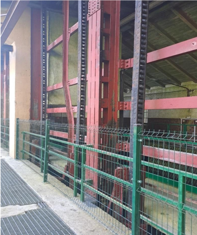
Rysunek 3. Prowadnice zasuw.
