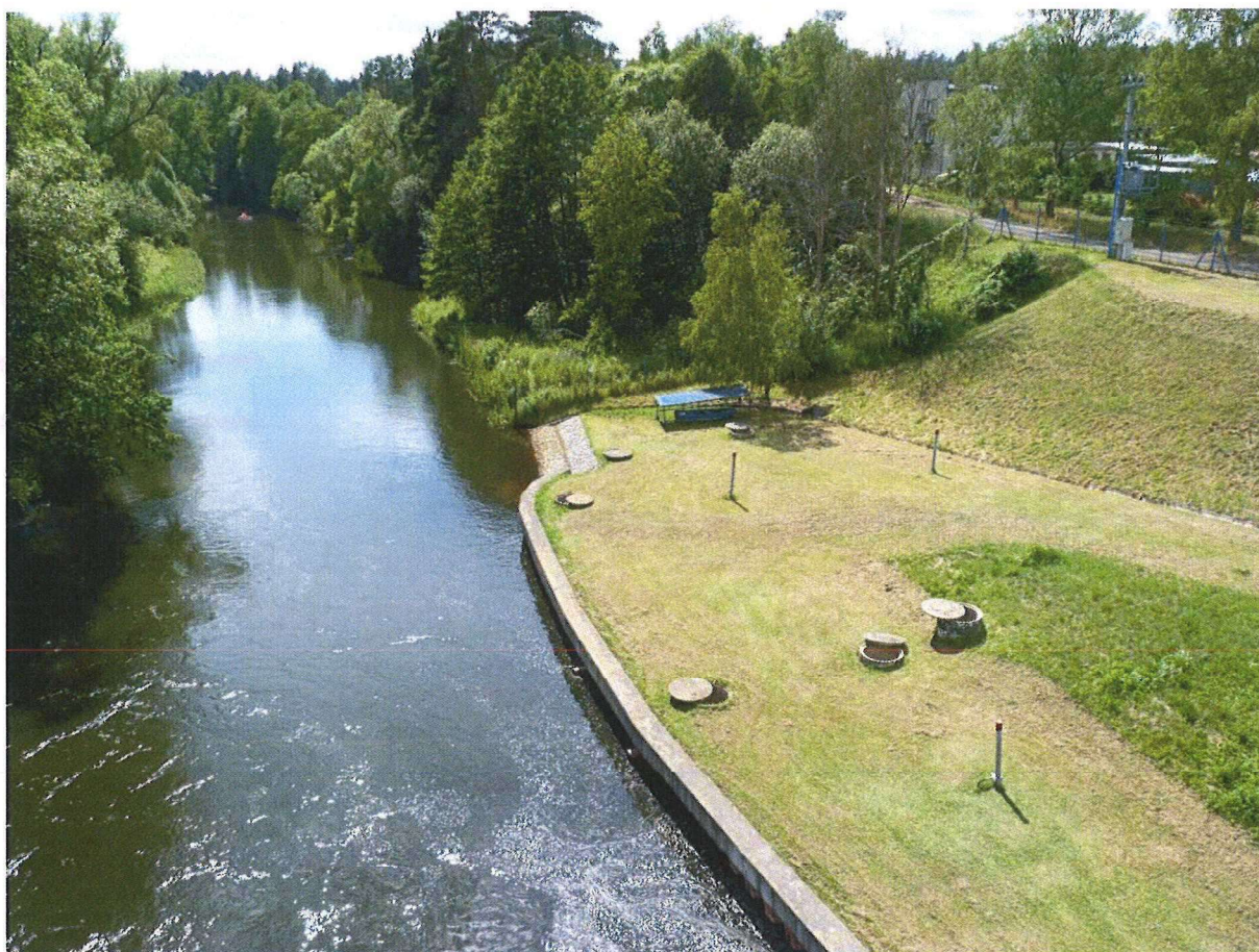
Fot. 1b – Ogólny widok na prawy brzeg dolnego stanowiska EW Podgaje.
