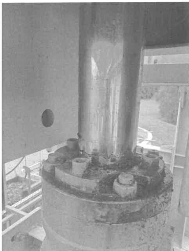
Rys. 3 Uszczelnienie siłownika zasuw
