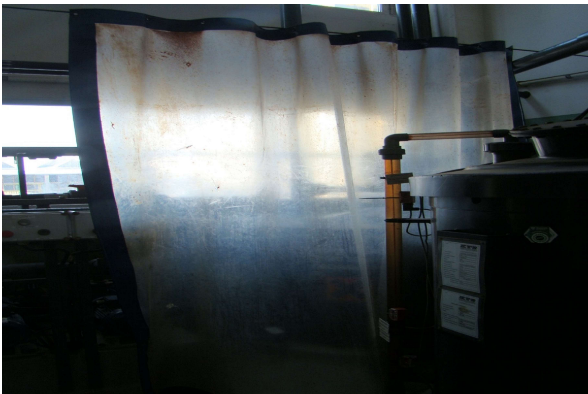
Fot. Nr 7 Widok na kurtyny osłonowe przy pompach rozładunkowych HCl i NaOH.
