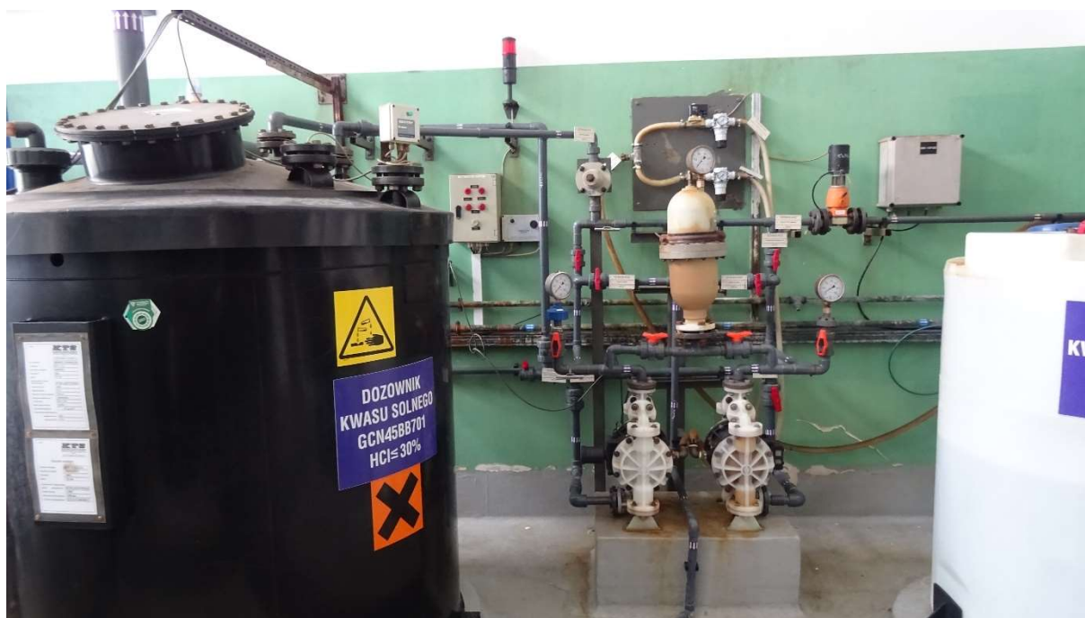
Fot. Nr 11. Układ pomp dozujących kwas solny HCl do regeneracji jonitów.
