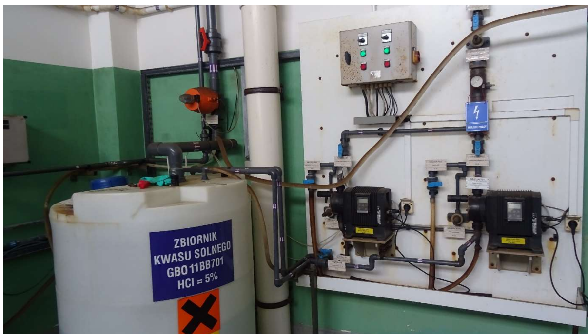
Fot. Nr 10. Układ pomp dozujących 5% kwas solny HCl do obiegu wody chłodzącej.
