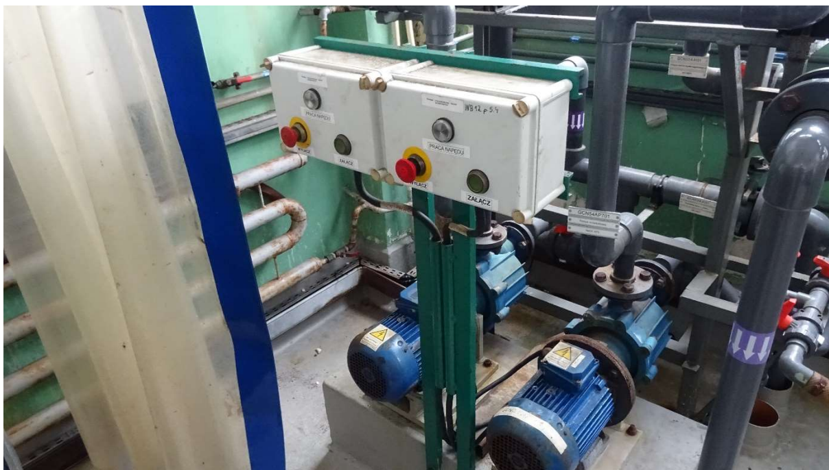
Fot. Nr 14. Widok na stanowisko pomp rozładunkowych NaOH.
