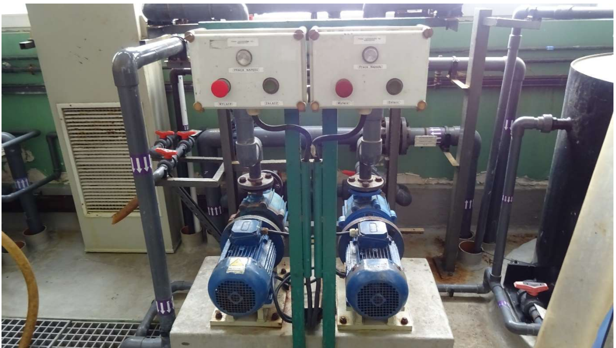
Fot. Nr 13. Widok na stanowisko pomp rozładunkowych HCL.
