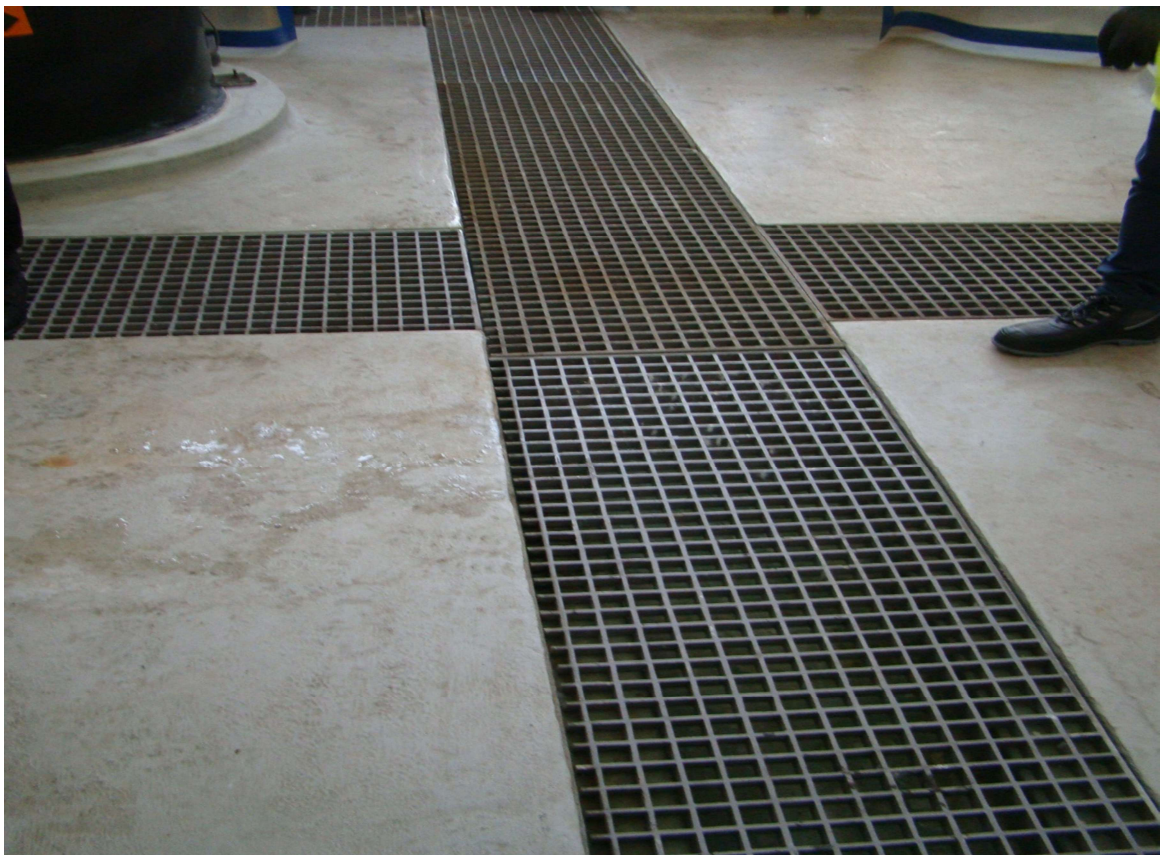
Fot. Nr 6. Widok na posadzkę i kanały odwodnieniowe pomieszczenia regeneracji.
