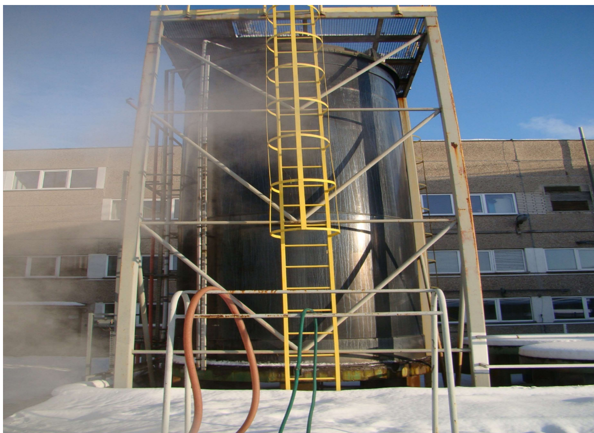
Fot. Nr 3. Widok na konstrukcję wsporczą w obrębie misy pod zbiornikami magazynowymi kwasu solnego.
