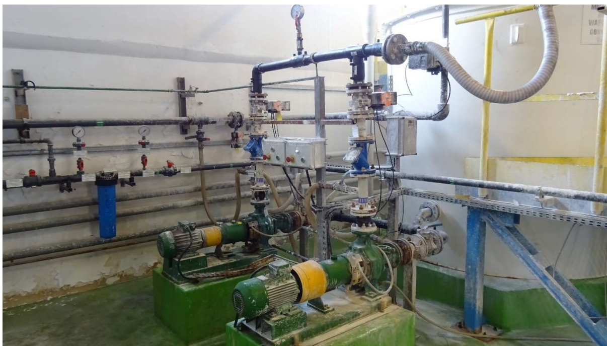
Fot. Nr 9. Widok na pompy dawkovania mleka wapiennego w budynku mleka wapiennego.
